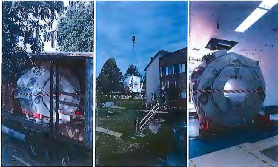
MR-kameran anländer till sjukhuset, lyfts in och installeras.
